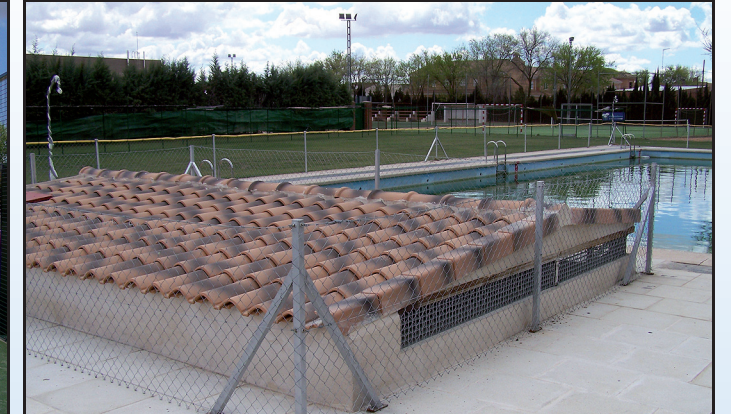
Nuevos vestuarios, nueva depuradora, son las mejoras que ha experimentado la Piscina Municipal
