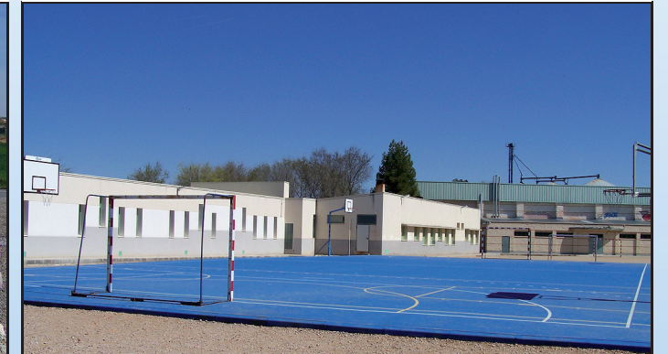
Un nuevo aulario y pistas deportivas han venido a mejorar las instalaciones del Colegio Público Ramón y Cajal
