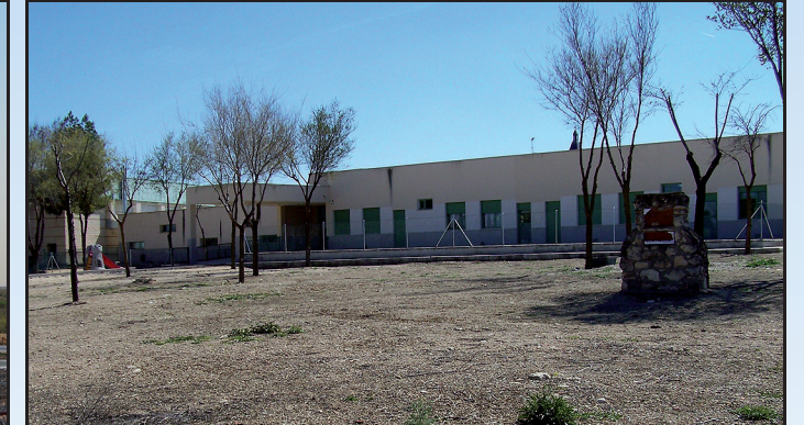
Terrenos donde se ubicará la Escuela Infantil, infraestructura fundamental cuya construcción ya ha sido licitada
